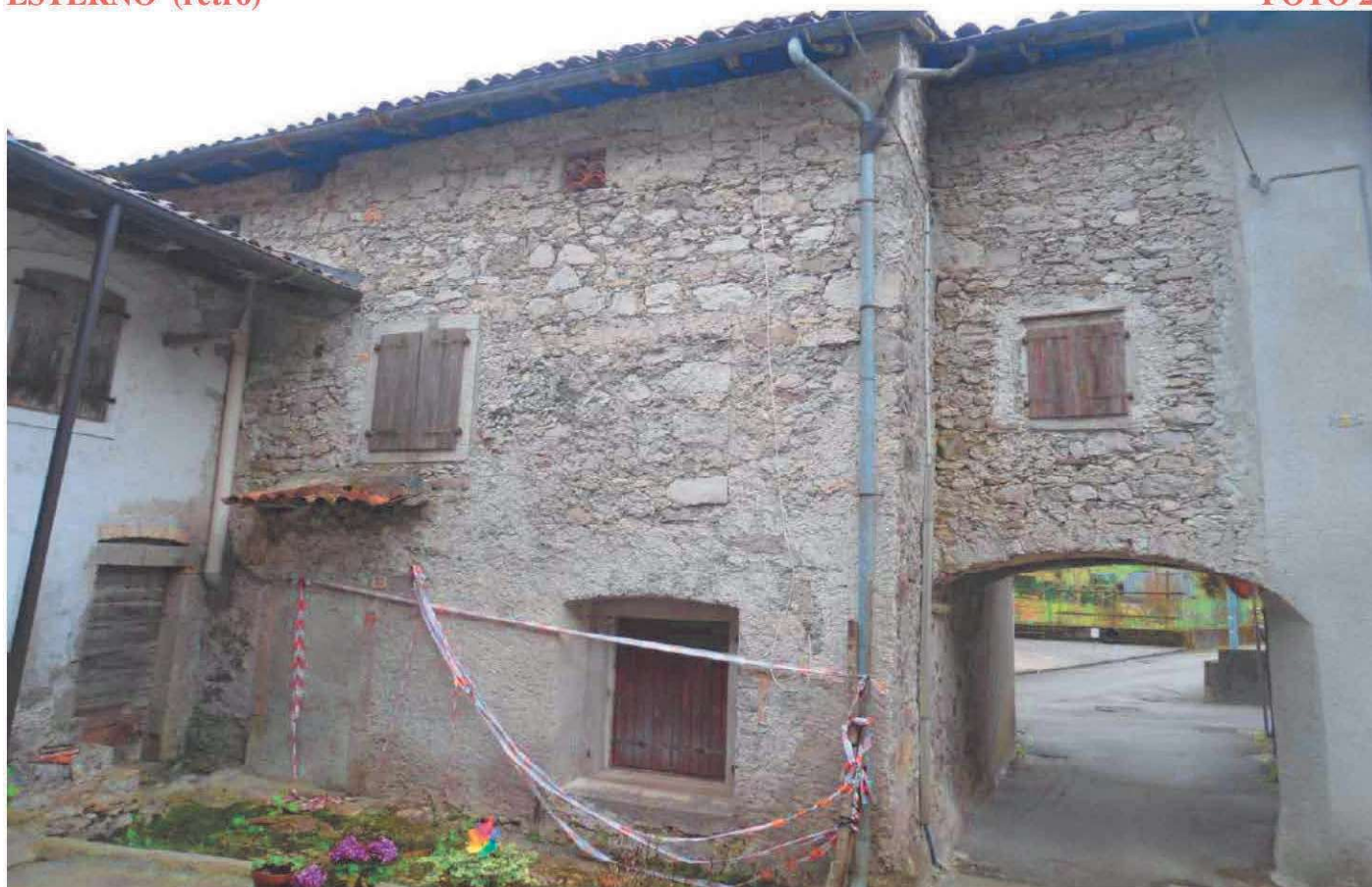
CORRIDOIO (piano terra)
